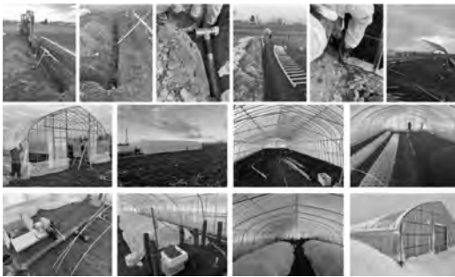
図10 浅層地中熱交換システムの構築風景
